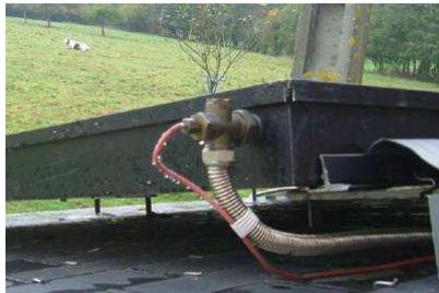
Traversée de toiture par percage des tuiles
