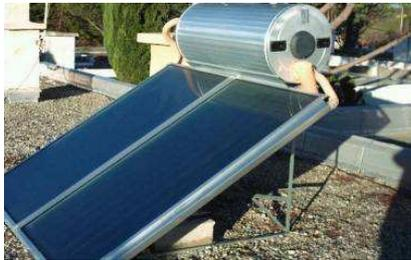
Fixation du capteur non conforme aux dispositions décrites dans l'Avis technique et dans les DTU de la série 40.
